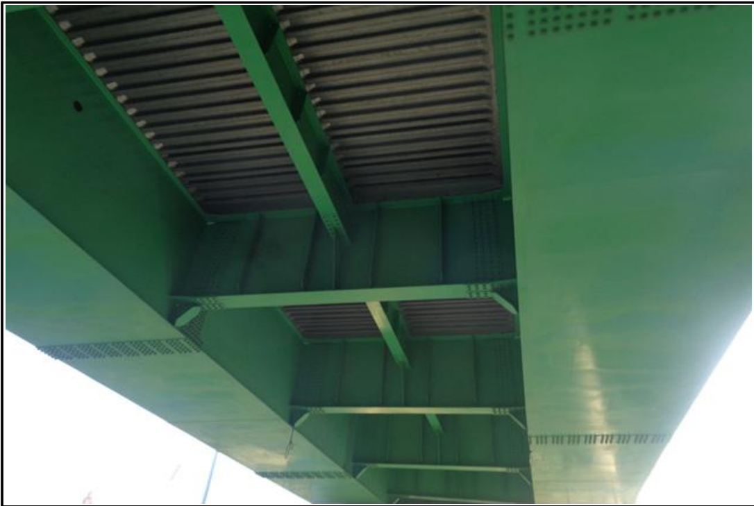
바닥판하면 및 거더 외부 전경
