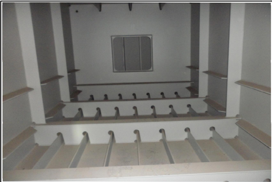
강박스 내부 전경
